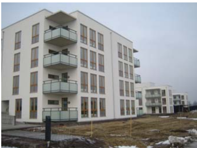
Figur 12. Kv Haga i Bunkeflo cirka 5 km söder om Malmö. Skanska bygger ca 200 lägenheter åt MKB Fastigheter fördelade på 10 hus. Produktionschef: Bengt Andersson Inflyttning dec 2005 och senare.
