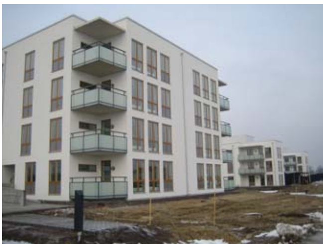
Figur 12. Kv Haga i Bunkeflo cirka 5 km söder om Malmö. Skanska bygger ca 200 lägenheter åt MKB Fastigheter fördelade på 10 hus. Produktionschef: Bengt Andersson Inflyttning dec 2005 och senare.
