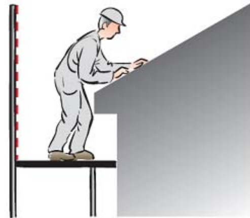
Byggnadsställning vid tak- och takfotsarbete.
