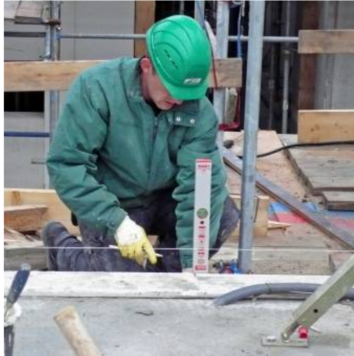
Dörröppning sätts ut
