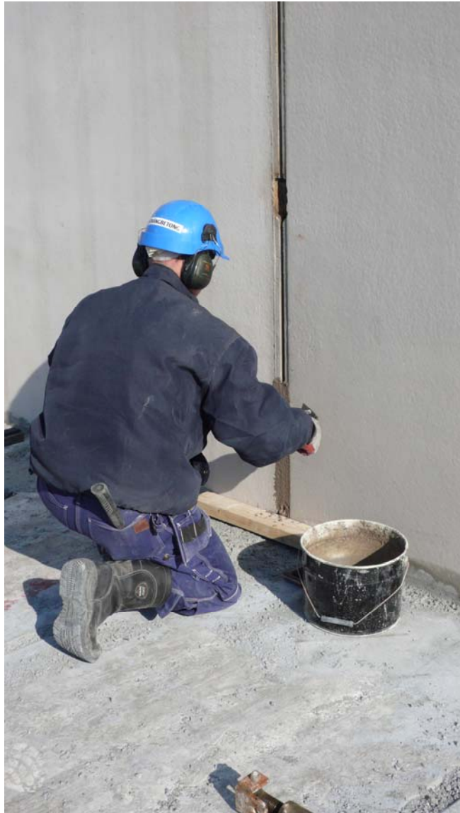
llagning av elementfogar
