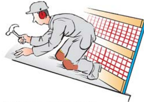
Skyddsräcke vid takarbete.
