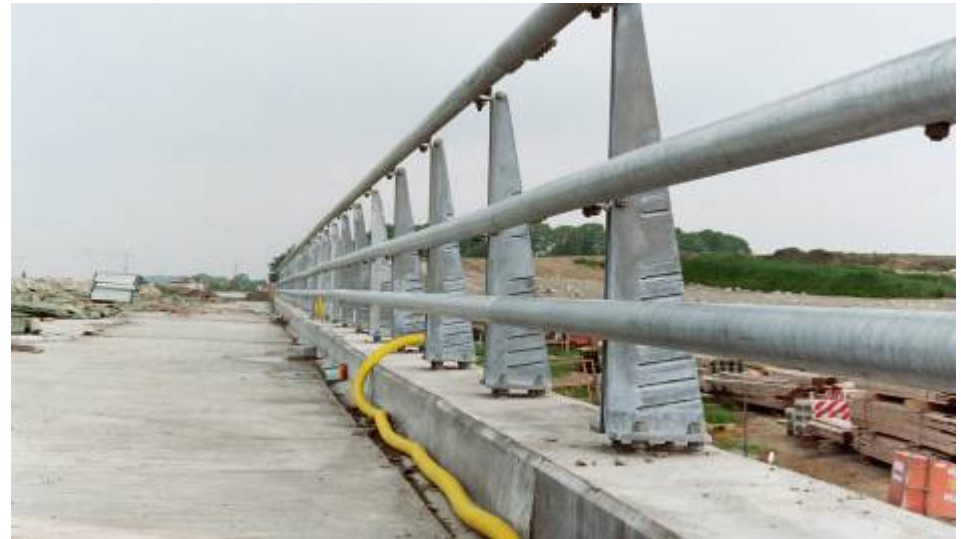
Räcken monteras.
