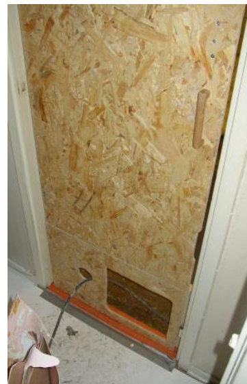
En provisorisk dörr med hål för kablar och luftrenare
