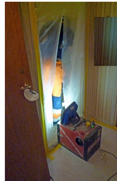
Inplastning och luftrenare minskar spridning av byggdamm
