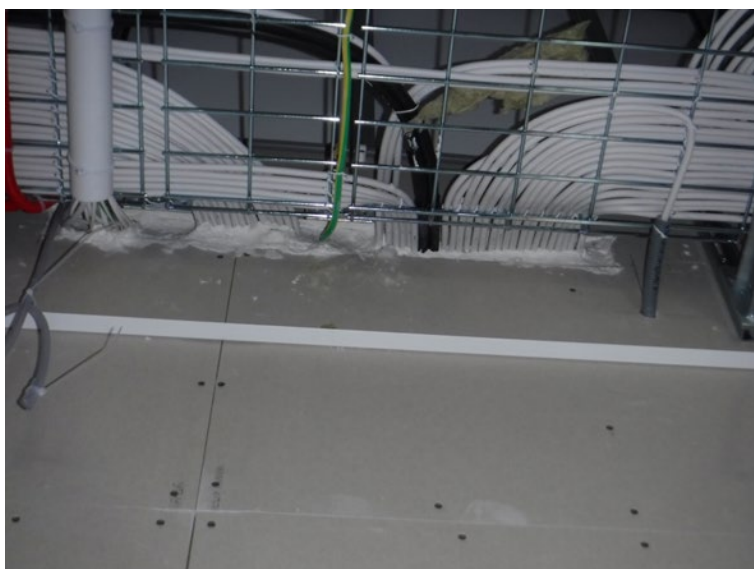
Figur 4.6.2 Omfattande kabelgenomföring tätad med fogmassa. Det finns bättre lösningar (Foto: E Gustafsson)
