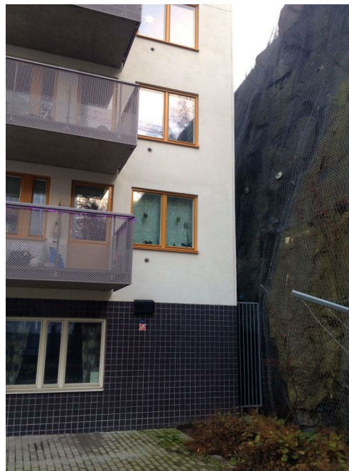
Figur 4.10 Exempel på bostadsprojekt där tomten utnyttjas maximalt genom att byggnaden placeras direkt mot intilliggande hinder. Här finns fönster som vetter direkt mot intilliggande klippvägg. (Foto: Paul Rogers).
