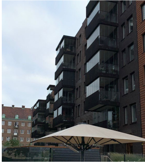
Figur 4.14 Mörka fasadmaterial lämnar mycket lite reflekterat ljus till gård och angränsande byggnader, här även svarta fönster och balkongfronter (Foto: Helena Bülow-Hübe).
