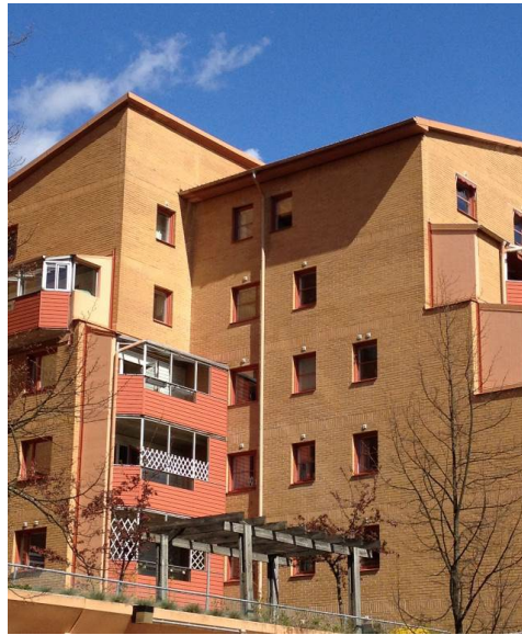
Figur 4.11 Byggnad från 1980-talet, då energifokus resulterat i att begränsa fönsterstorlekarna, vilket leder till relativt mörka rum (Foto: Paul Rogers).
