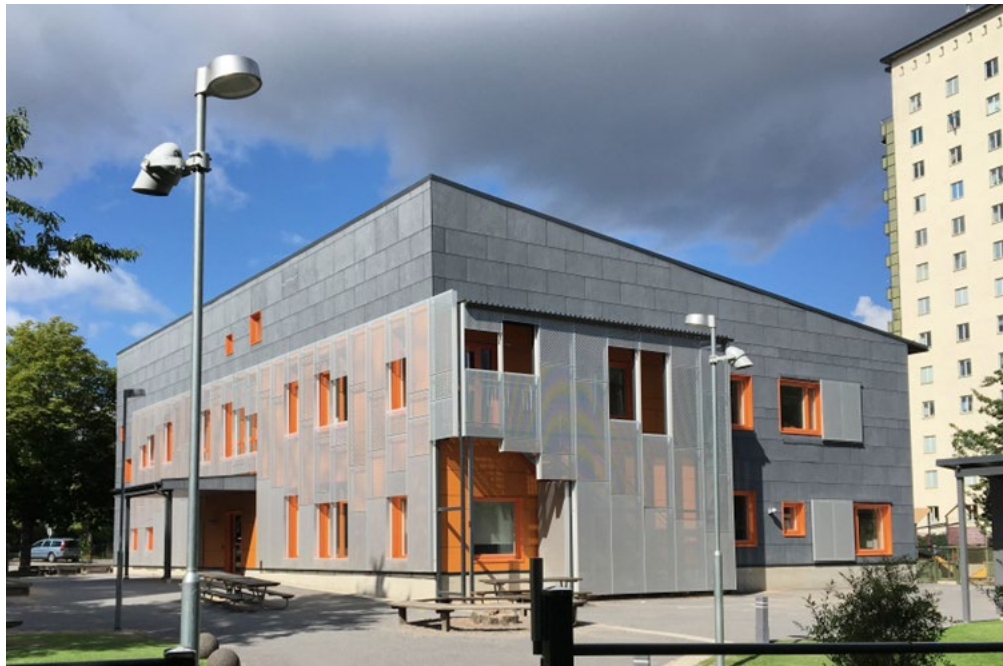
Figur 4.13 Nybyggd förskolebyggnad med små fönster och avskärmning av dagsljus från fasadelement. I byggnaden finns rum som inte uppfyller BBR:s dagsljuskrav trots att byggnaden i stort sett inte skyms av omkringliggande byggnader. (Foto: Paul Rogers).
