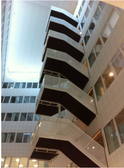
Figur 4.12 Minskad glasarea i nybyggt kontorshus som i kombination med små gårdar resulterar i mycket låga dagsljusnivåer i intilliggande kontorsutrymmen. (Foto: Paul Rogers).
