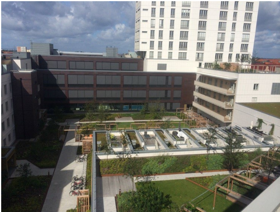
Figur 3.5 Exempel på olika slags solavskärmning. Den bruna fasaden är försedd med utvändigt mörk screenväv som är nerfälld i bilden. Till höger i bild finns balkonger/loftgångar som skuggar fönstren. Det vita uppstickande huset är försedd med mellanglaspersienner, och man kan tydligt se vilka fönster som har dem nerfällda. (Foto: Helena Bülow-Hübe).
