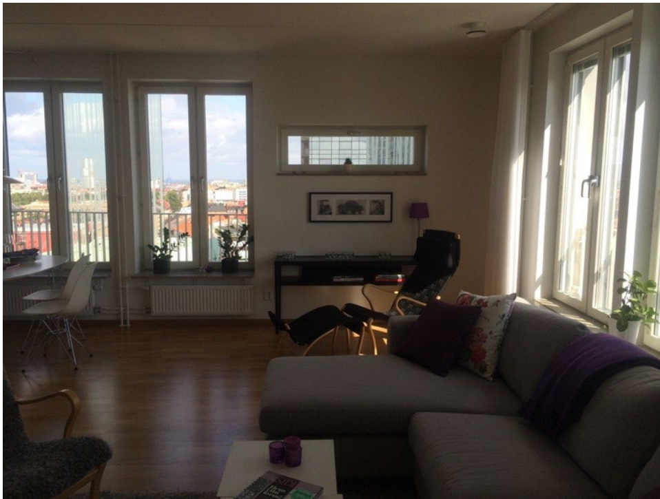
Figur 3.7 Interiör från modern lägenhet där fönster utförts som kopplade (1+2) med mellanglaspersiennier i östligt väderstreck (till höger i bild) och utan persiennier åt norr (fönstren till vänster i bild). (Foto: Helena Bülow-Hübe).
