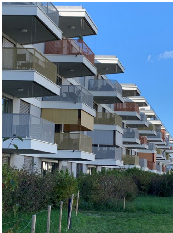
Figur 3.4 Exempel på balkonger med solavskärmade screenvävar, eller vertikalmarkiser. Från stadsdelen Erlenmatt i Basel, Schweiz. (Foto: Helena Bülow-Hübe).
